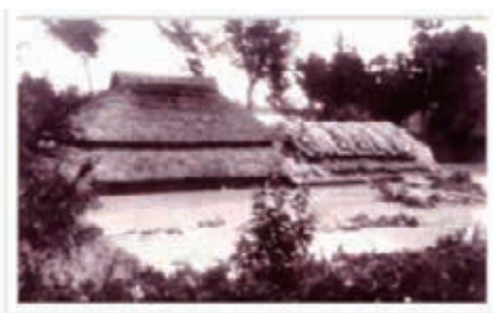
▲軒下まで水没した家屋(大川戸地区)
