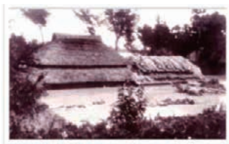
▲軒下まで水没した家屋(大川戸地区)
