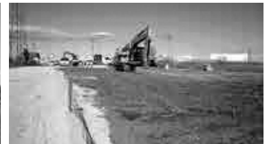
旭橋西側付近の盛土工事
