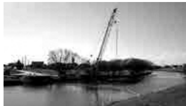
大落古利根川架橋の橋脚工事
