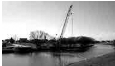
大落古利根川架橋の橋脚工事
