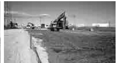
旭橋西側付近の盛土工事
