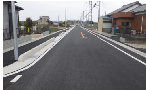
工事完成箇所
