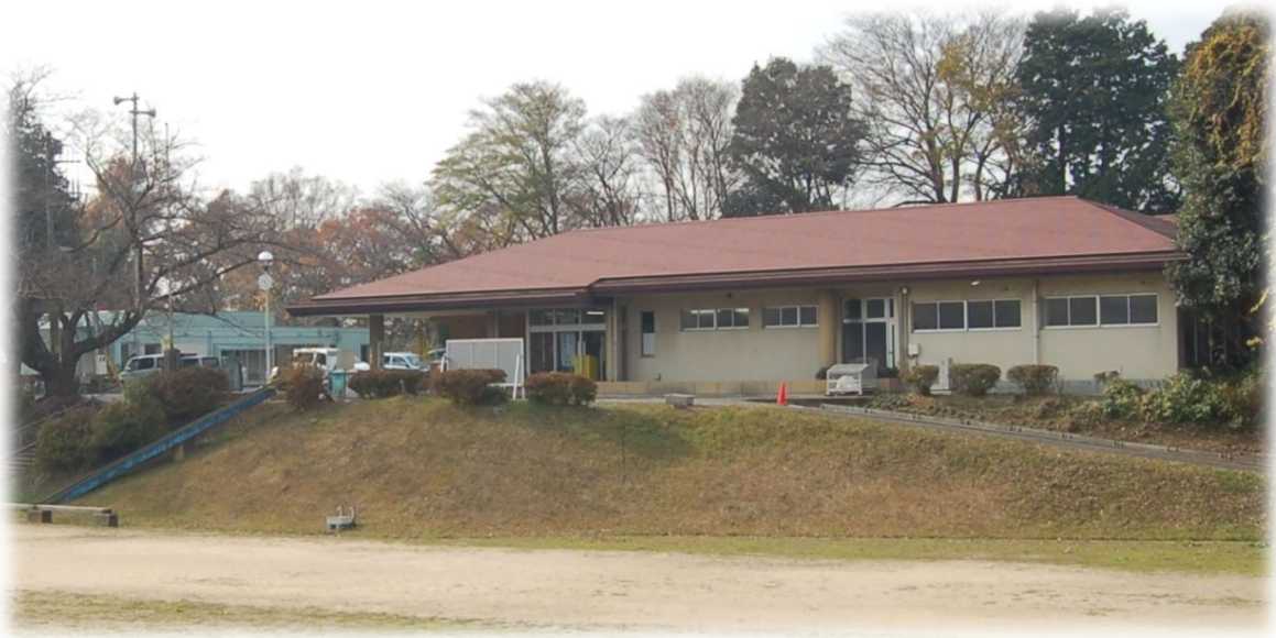
北部サービスセンター（旧老人福祉センター）（右上）、 農村トレーニングセンター（左上）及び農村ひろば（手前）
