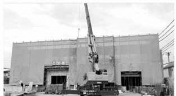
建設が進む松伏町新保健センター
