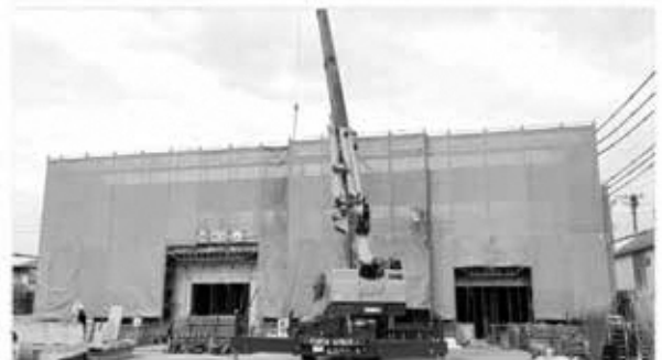
建設が進む松伏町新保健センター
