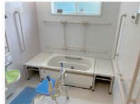
手すりの多い個浴
