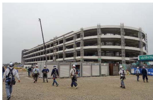
建設中の(株)丸和運輸機関倉庫
