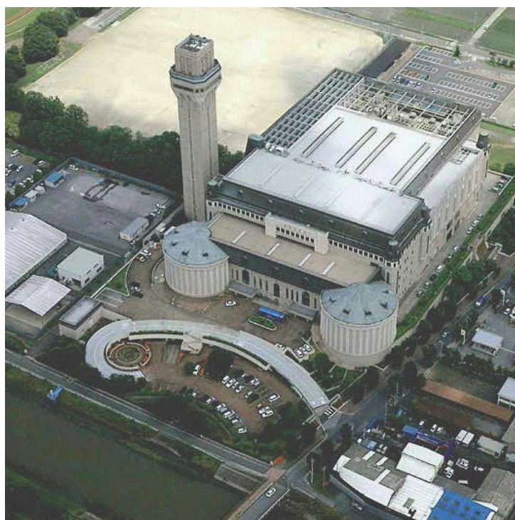
図3-3 東埼玉資源環境組合第一工場ごみ処理施設
