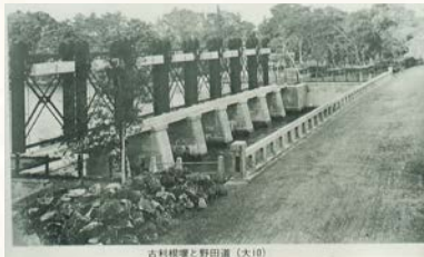
▲大正10年(1921)に初めて鉄筋コンクリートで作られた古利根堰。これに代わるまでは享保15年(1730)につくった堰枠を使用。
