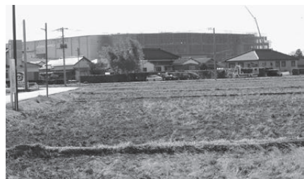
大川戸地区に建設中の巨大物流センター。松伏・田島産業団地には、この規模の物流倉庫群が複数棟建設される計画で、周辺住宅地への影響は計り知れない。
