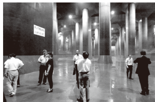
地下50mの首都圏外郭放水路
