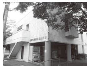
本年度改修工事される赤岩地区公民館
