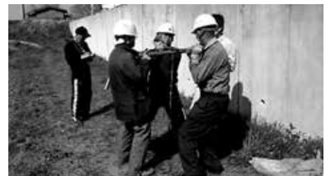
▲金杉地区ボーリング調査
