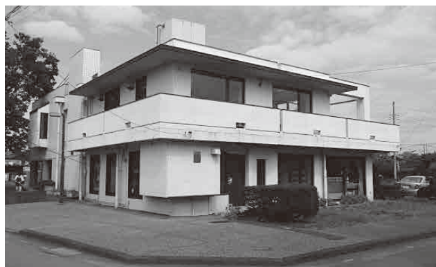
改修される赤岩地区公民館(玄関とされる南側)
