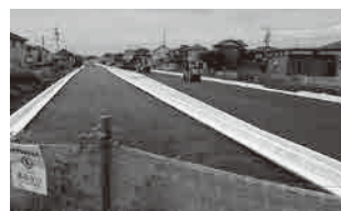
工事中の浦和野田線
