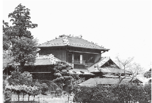
東日本大震災で破損した屋根
