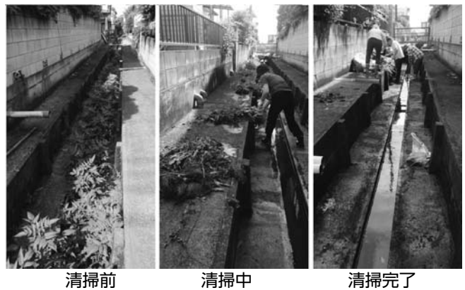
町内排水路清掃
