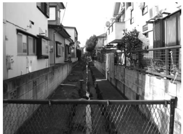
排水路の現状
