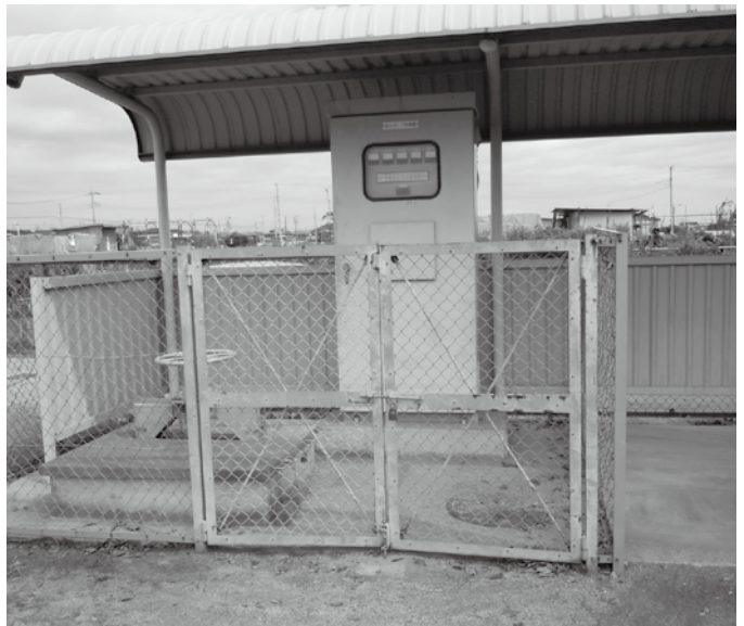
浸水した配電盤
