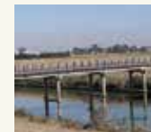
赤岩橋 橋長 60.1m 架設年 1958年
