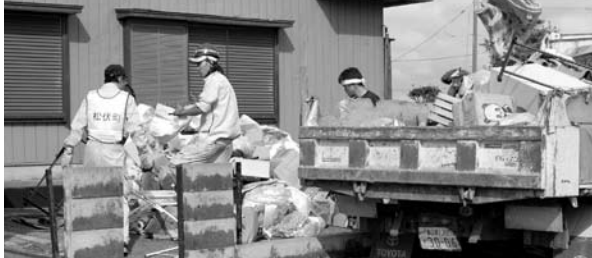
▶ がれきの撤去作業
